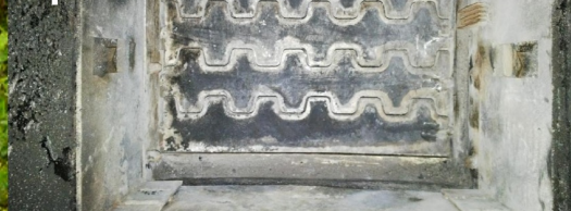
Limpieza automática de la parrilla
